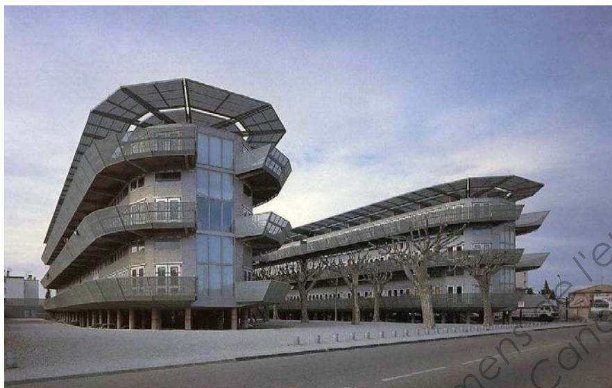
Vue générale sur les deux bâtiments
